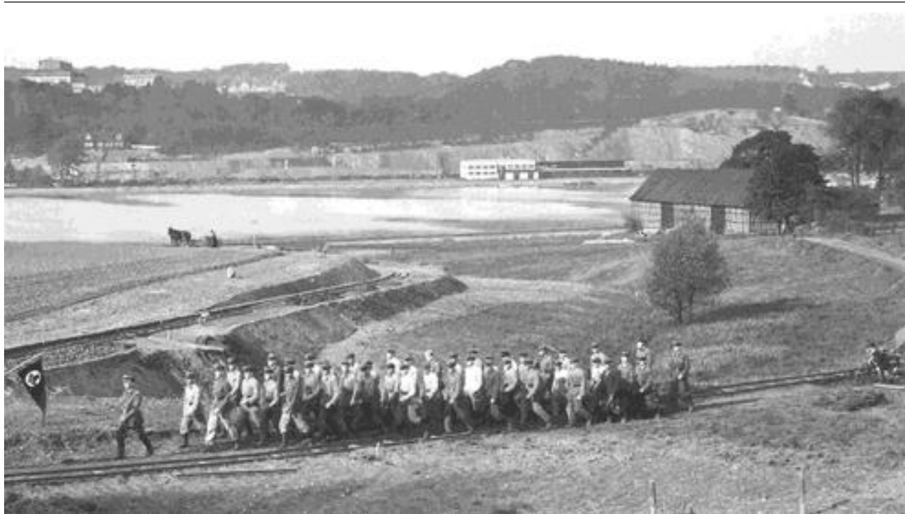
Arbeitskolonne beim Bau des Baldeneysees 1932, im Hintergrund das neue Bootshaus
