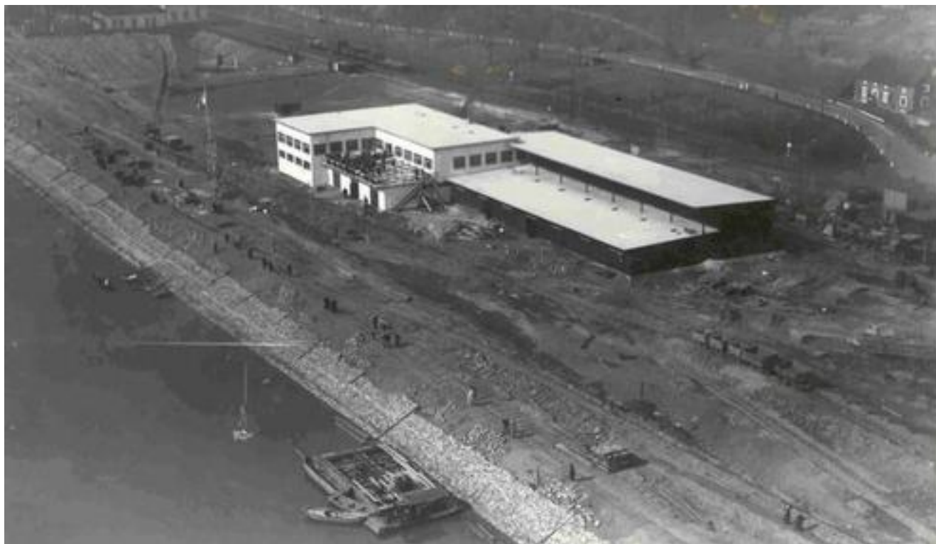
Das Gemeinschaftsbootshaus am heutigen Standort des RaB kurz vor der Fertigstellung 1933, im Vordergrund der aufgestaute Baldeneysee. Das Haus besaß 10 Bootshallen, von denen 5 Hallen im Anbau auf der rechten Seite den Schülerriegen zugewiesen waren.
