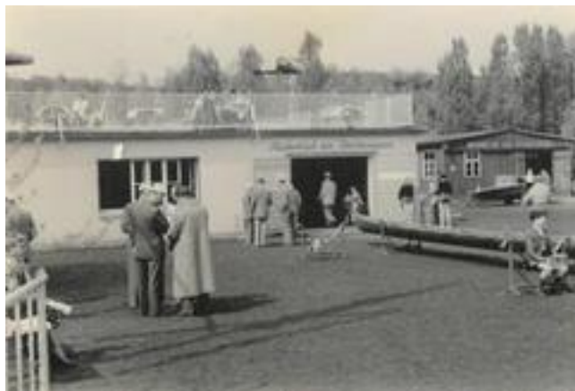
Der erste Bauabschnitt des neuen Bootshauses, rechts daneben die Baubaracke
