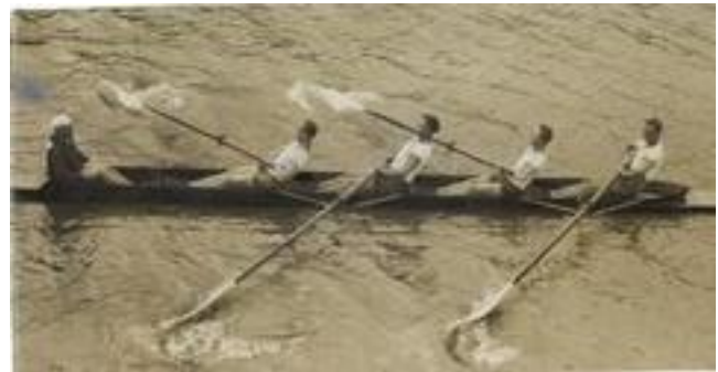
Kurze Rollbahnen, extreme Rückenlage: Orthodoxe Rudertechnik
